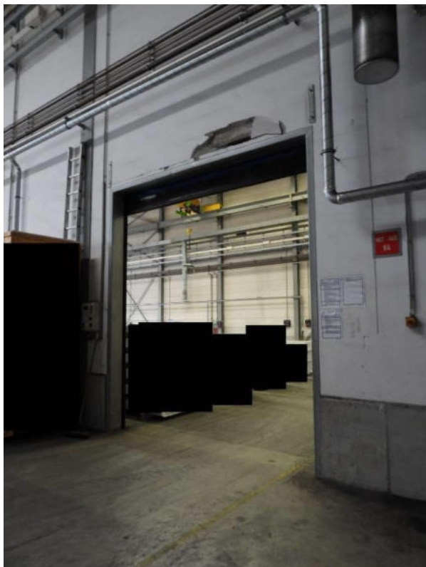
Torsturz schadhaft Übergang zwischen den Trakten
