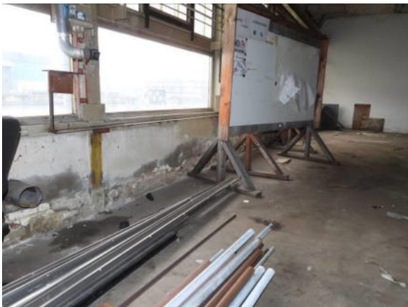
Erdgeschoss | Feuchteschäden an den Außenwänden
