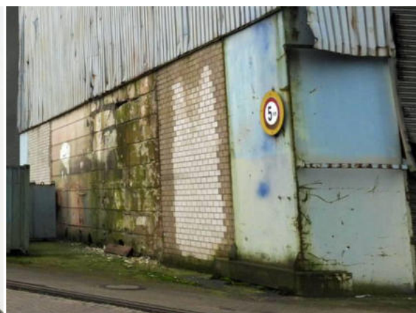
nördliche Fassade | diverse Feuchteschäden
