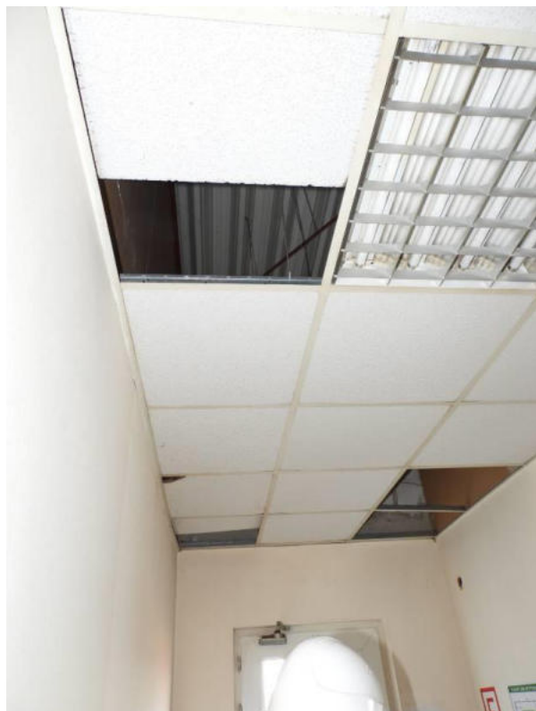
Akustikdecke mit Feuchteschäden und fehlenden Deckenplatten
