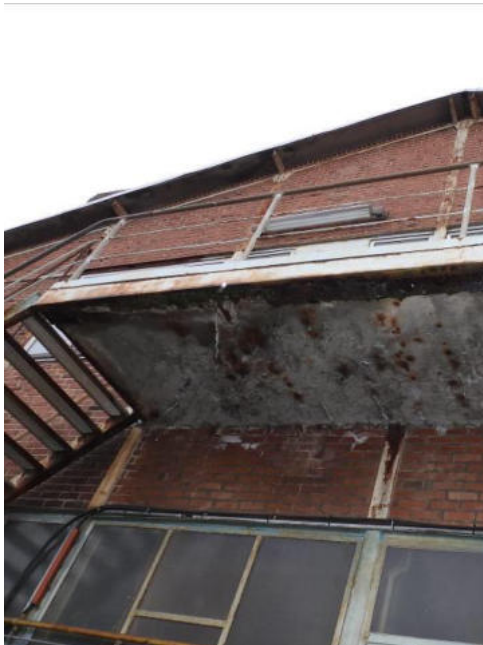
Treppenkragarm korrodiert
