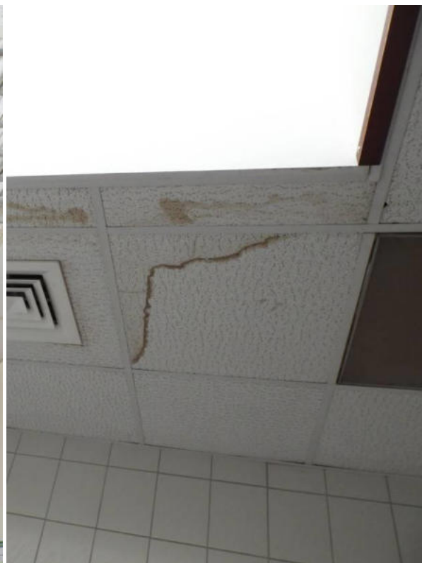
Akustikdecke mit Feuchteschäden und fehlenden Deckenplatten
