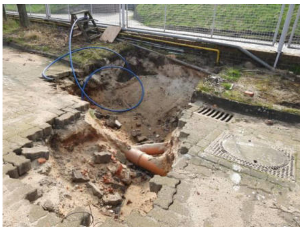
Aufgrabungen wegen defekter Wasserleitungen vor Container-Lärmschutzwand
