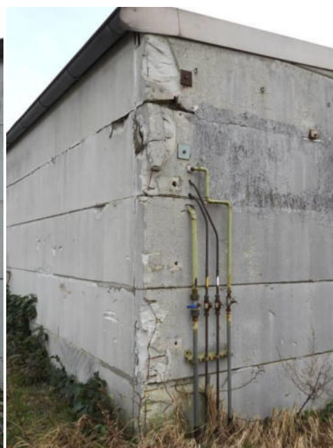
Entwässerung schadhaft, diverse Fassadenschäden
