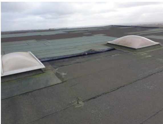
Bitumenbahnen abgängig
