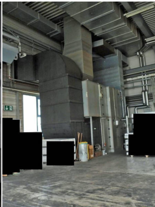
Hochvakuum-Absaugungs-Anlage
