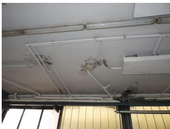
diverse Feuchteschäden an der Erdgeschossdecke
