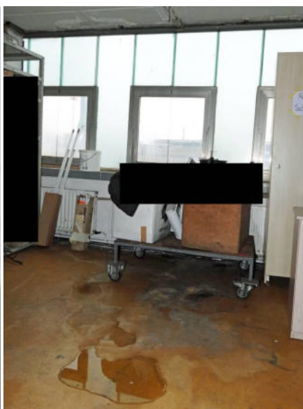
Wassereinbruch durch das Dach
