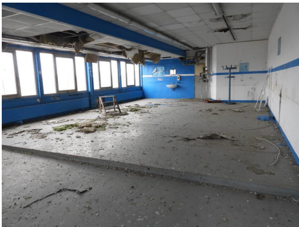
Obergeschoss | Akustikdecke abgängig, Verschmutzung durch Taubenkot
