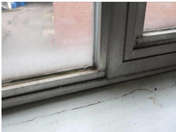
Fenster undicht
