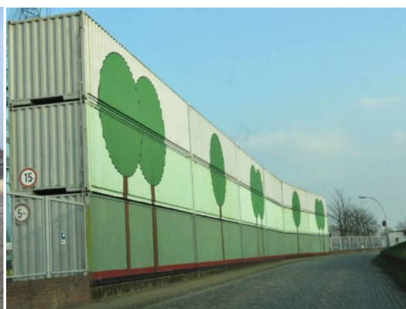
Lärmschutzwand als Containerwand an der südlichen Grenze
