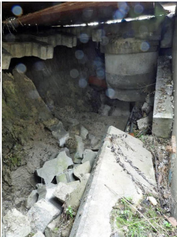
Schäden unterhalb der alten Kaianlage
