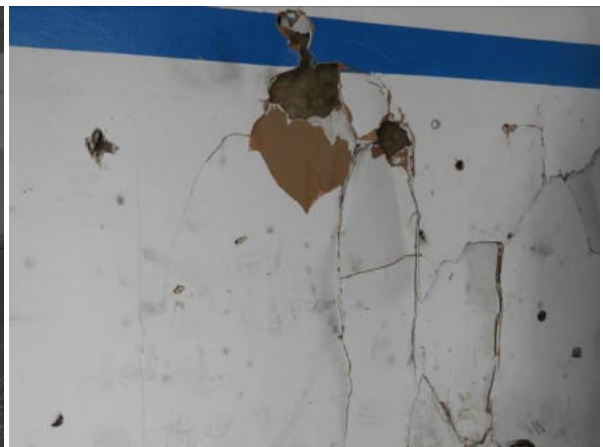
Obergeschoss | Decken-, Wand- und Bodenbeläge abgängig, Verschmutzung durch Taubenkot
