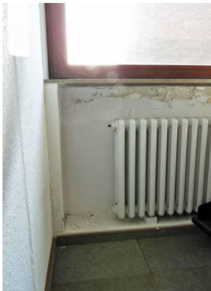
Heizkörper in Fensternischen, diverse Feuchteschäden
