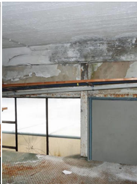
Obergeschoss | Feuchteschäden
