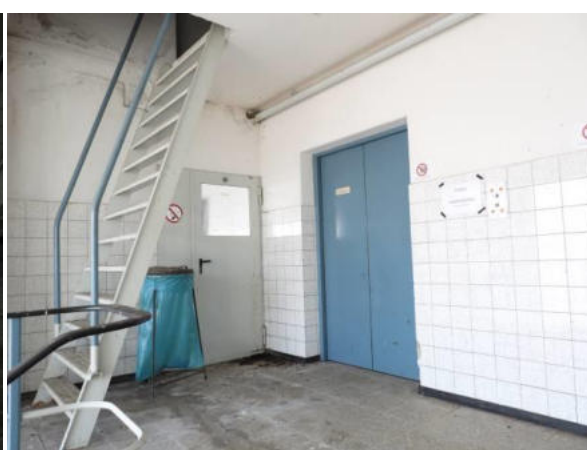
Treppenhaus mit diversen Feuchteschäden
