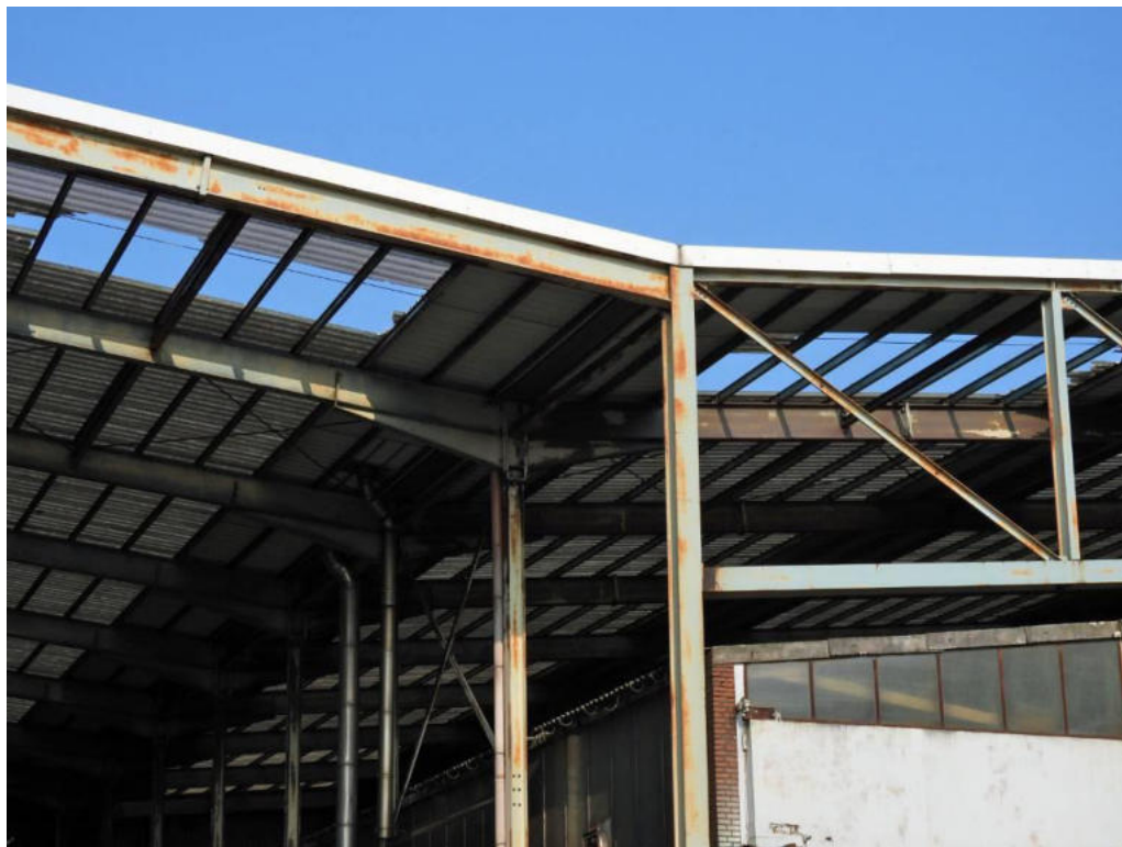
Halle 53 | Dachfläche schadhaft
