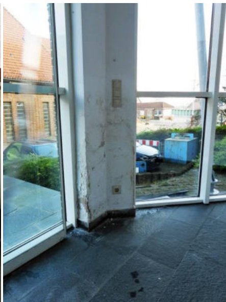
Heizkörper in Fensternischen, diverse Feuchteschäden
