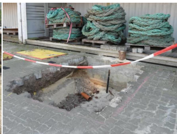
Aufgrabungen wegen defekter Wasserleitungen vor Container-Lärmschutzwand
