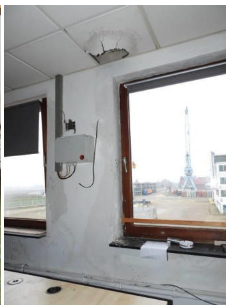
Feuchteschäden im Anbau
