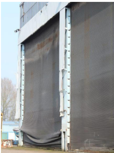
Rolltor mit Sturmschaden
