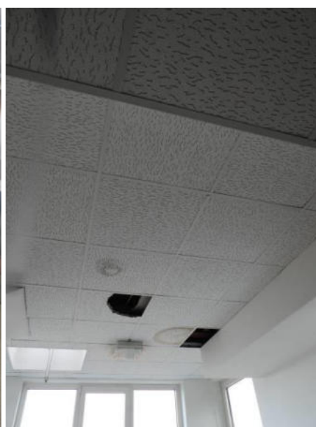
Schäden an der Akustikdecke
