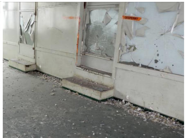
Obergeschoss | Akustikdecke abgängig, Innentüren eingeschlagen, Verschmutzung durch Taubenkot
