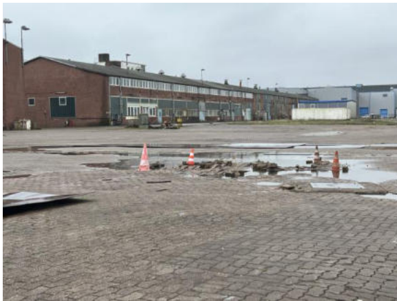
Absackungen der Pflasterung, hier zw. Halle 11 und 24
