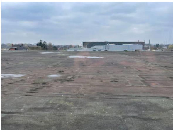
Bitumenbahnen wellig, abgängig
