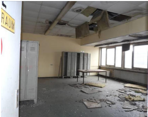
Obergeschoss | Akustikdecke abgängig, Innentüren eingeschlagen, Verschmutzung durch Taubenkot
