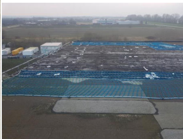
Leitungen entlang der östlichen Grundstücksgrenze | Netze auf der Dachfläche, zur Sicherung abgerissener Dachteile
