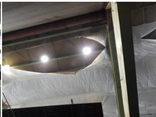
Dachfläche undicht, in der Folie steht Wasser
