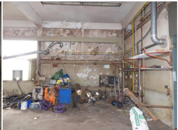
Erdgeschoss | Feuchteschäden an den Außenwänden
