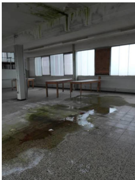
diverse Feuchteschäden und Schimmelbefall
