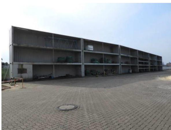
Lärmschutzwand als Containerwand an der südlichen Grenze
