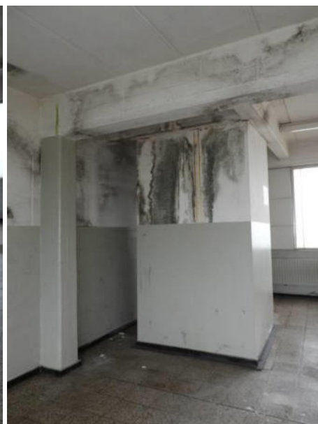
diverse Feuchteschäden und Schimmelbefall
