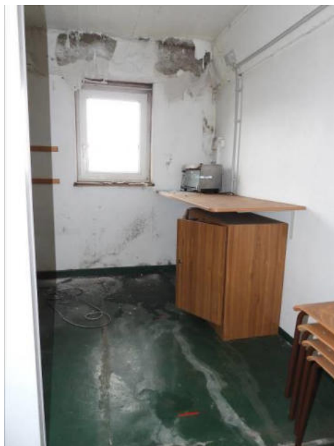
Obergeschoss | Feuchteschäden
