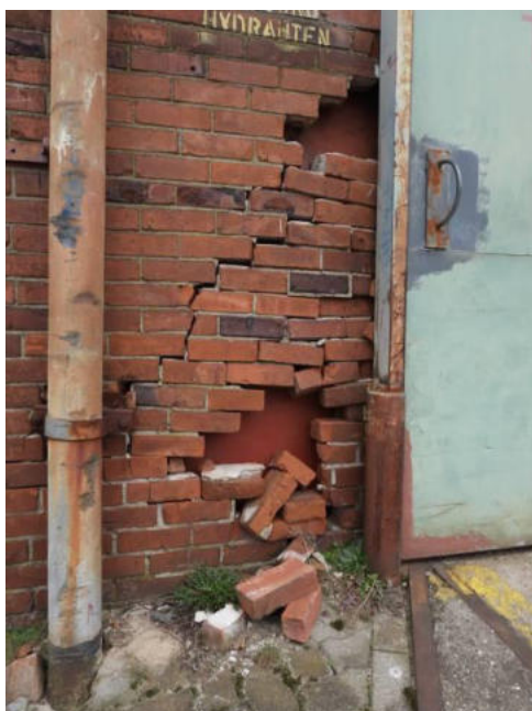
Schäden an den Außenwänden
