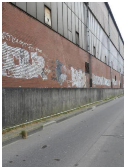
Ostfassade | diverse Graffiti, Ausblühungen, Korrosion | Stahlbetonwand als Hochwasserschutz
