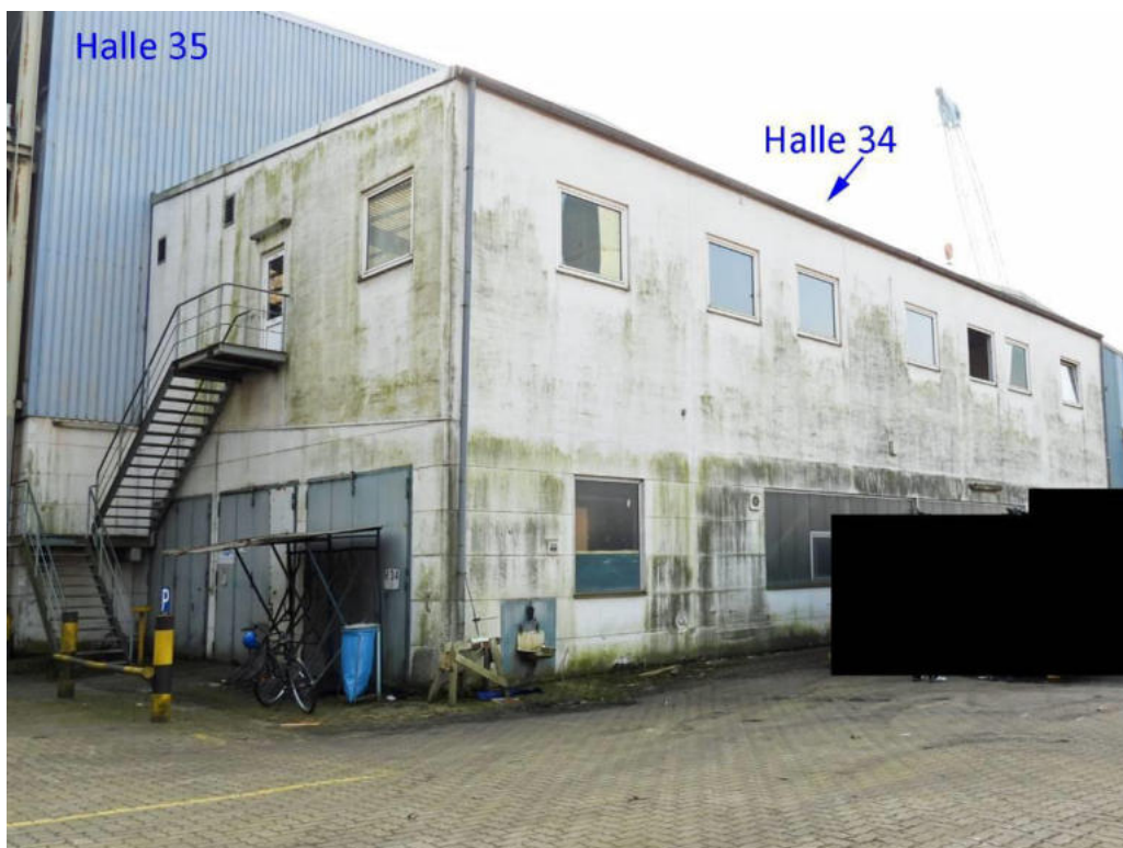
Nord- und Ostfassade | Grünbelag an der Putzfassade
