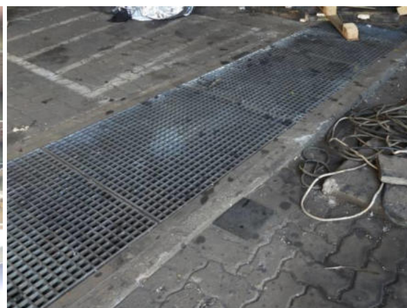
Lüftungsgraben
