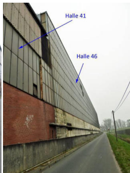
Ostfassade | diverse Graffiti, Ausblühungen, Korrosion | Stahlbetonwand als Hochwasserschutz
