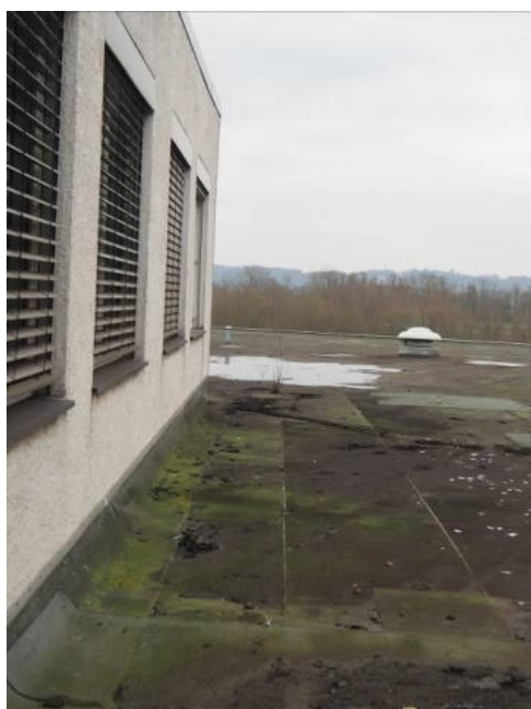
diverse Undichtigkeiten in der Dachfläche
