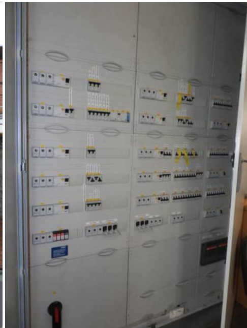
Elektro-Sicherungskasten mit Kippsicherungen
