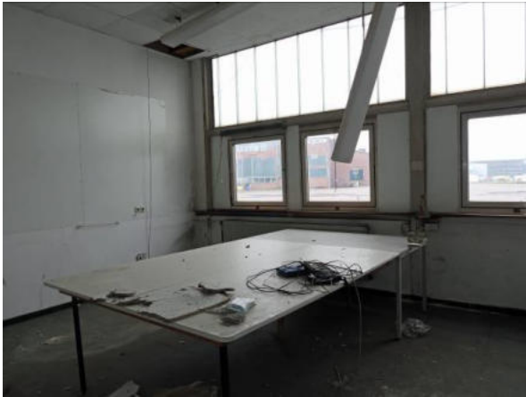
Erdgeschoss Büro | Akustikdecken abgänglich
