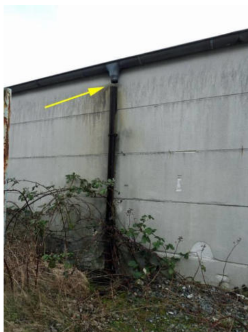
Entwässerung schadhaft, diverse Fassadenschäden
