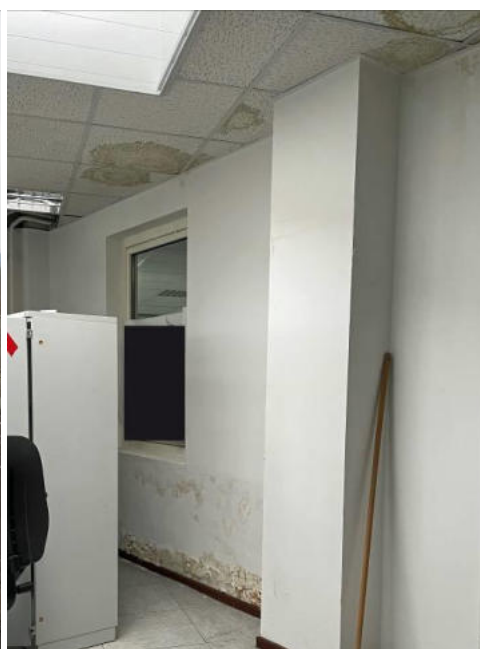
diverse Undichtigkeiten in der Dachfläche
