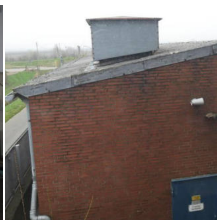
Dachfläche | Wellasbest
