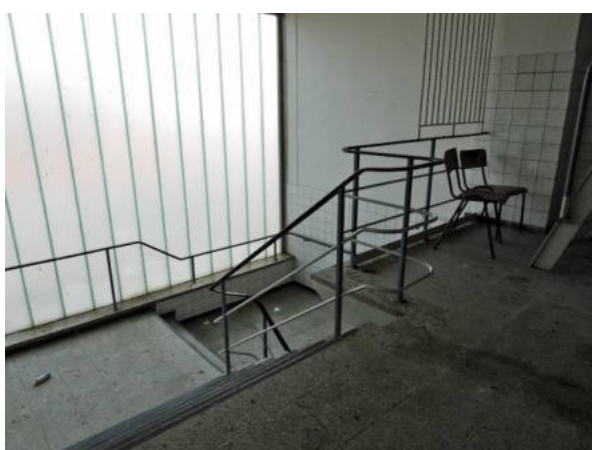
Treppenhaus mit diversen Feuchteschäden
