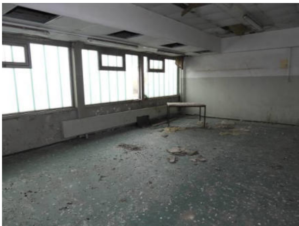
Obergeschoss | Decken-, Wand- und Bodenbeläge abgängig, Verschmutzung durch Taubenkot
