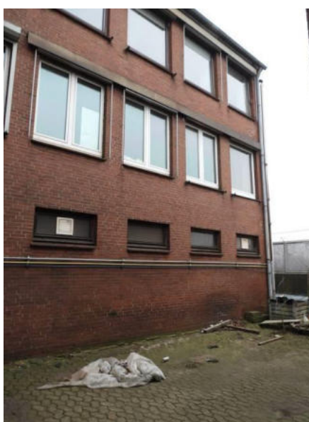
Leitungsführung vor der Außenwand
