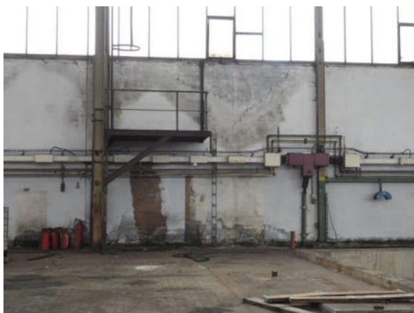
Feuchteschaden Außenwand
