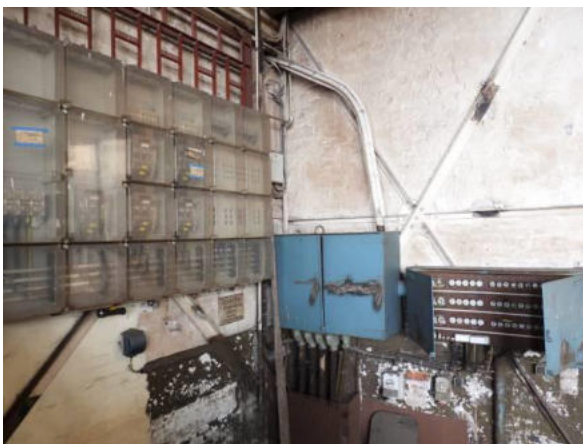
veraltete Elektrokästen im Ursprungsgebäude
